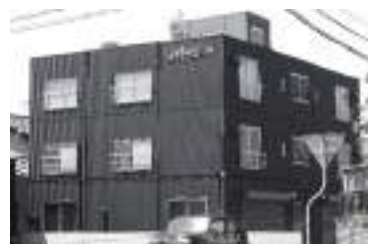
解体が決定した事務所
